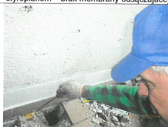
Fot. 26 Widok fragmentu taśmy wzmacniającej (żółta) naroże poziome w korytku odwadniającym.
