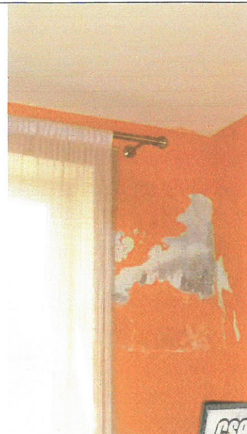
Fot. 6 Lokal „Ognisty smok” zniszczenia powłoki malarskiej – wrzesień – zniszczenia wynikają ze zbyt szczelnego tynku i le dobranej powłoki malarskiej oraz prawdopodobnie przemarzania narożnika północno-zachodniego w prześwicie – zaleca się badania termograficzne
