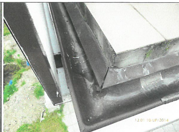
Fot. 16 Narożnik południowo-wschodni tarasu nad lokalem przychodni – brak rąbka na obróbce narożnej tarasu, rynny PCV klejone taśmą – uszczelnienie przecieków?
