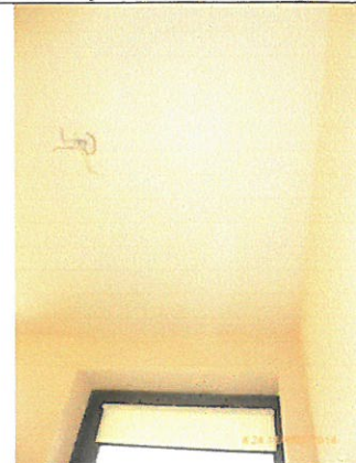
Fot. 8 Lokal przychodni, rejestracja – w wyniku przecieków z tarasu uszkodzone zostało oświetlenie pomieszczenia
