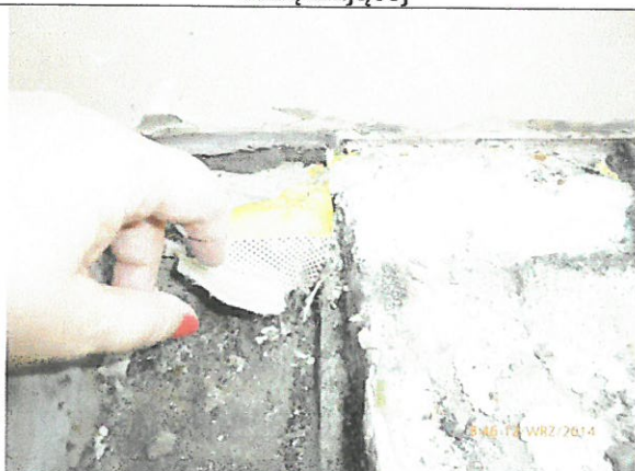
Fot. 27 Taśma wzmacniająca J i R – r w korytku odwadniającym – niewklejona w naroże, widoczna siatka taśmy odstająca od ściany pod masą mineralną
