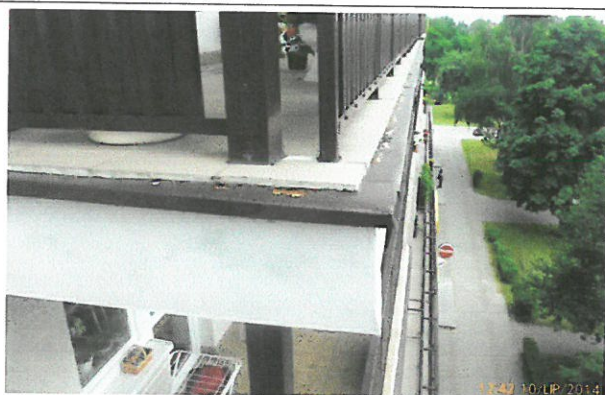
Fot. 37 Balkon – widoczna korozja na obróbkach blacharskich brak maty drenującej i zabezpieczenia obróbki
