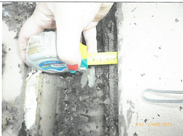
Fot. 29 Głębokość ubytków 2,7 cm w skorodowanej masie mineralnej pod przyklejoną płytką w sąsiedztwie korytka odwadniającego
