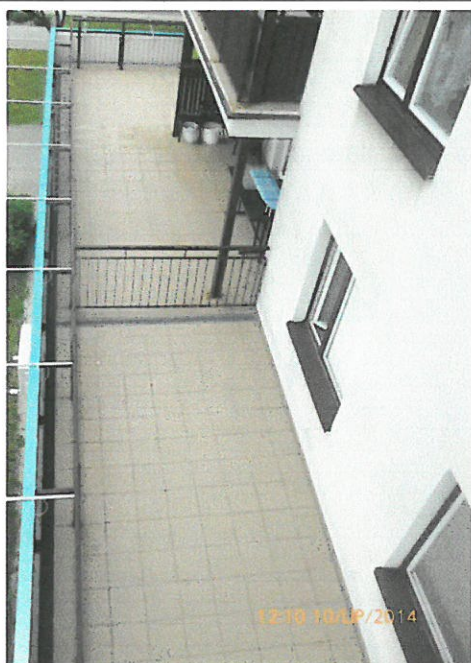
Fot. 21 Widok tarasu południowego – wylana woda na tarasie nie spływa do korytek odwadniających, tylko pasami po trzech spoinach
