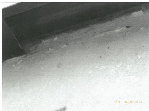
Fot. 20 Widok elewacji ze złuszczeniami pod obróbką blacharską tarasu – uszkodzenia nasilone na ok. 10 cm pod pasem podrynnowym
