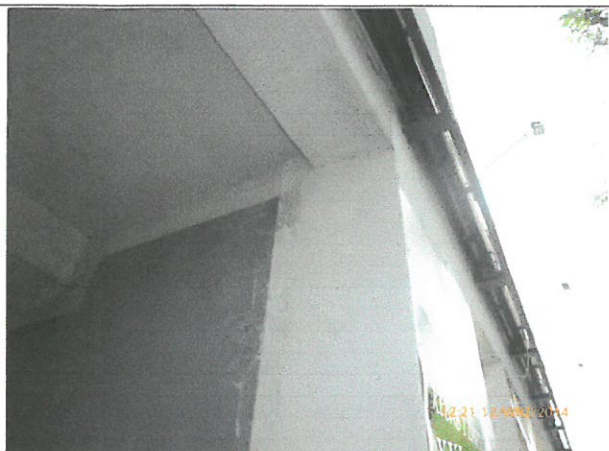
Fot. 11 Narożnik prześwitu północno-zachodni sąsiadujący z lokalem „Ognisty smok” – stwierdzono wykwyty solne, bez korelacji z tarasem
