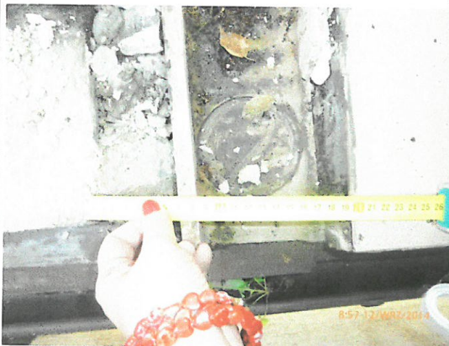
Fot. 35 Odkrywka nr 2 przed wykonaniem odkrywki nr 3 – widok z góry na nakładkę blacharską i uzupełnienie masą mineralną grubości 7 cm – w dekielku korytka woda
