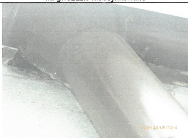
Fot. 19 Widok sztucera pod którym wycięto obróbkę blacharską tarasu
