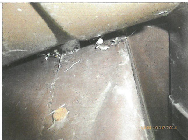
Fot. 17 Narożnik południowo-wschodni tarasu nad lokalem przychodni – połączenie obróbki ze ścianą na gwoździe nieocynkowane
