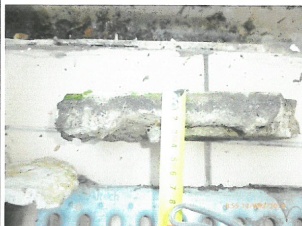
Fot. 32 Odkrywka nr 2 – uzupełnienie z masy mineralnej od czoła gr. 2,5÷3 cm – stanowi zabezpieczenia czoła tarasu bez obróbki blacharskiej
