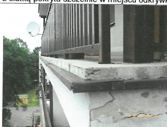
Fot. 38 Balkon – widoczna korozja czoła płyty balkonowej i brak połączeń dekarskich na obróbkach blacharskich
