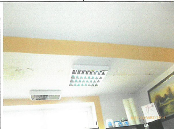
Fot. 10 Księgarnia, widoczne liczne zacieki wynikające z przecieków tarasu
