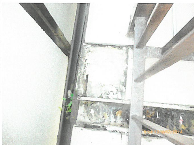
Fot. 31 Odkrywka nr 2 – widoczne uzupełnienia z masy mineralnej od czoła i korytka odwadniającego
