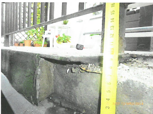
Fot. 33 Odkrywka nr 2 – widoczne uzupełnienia z masy mineralnej – pomiar grubości płyty dociskowej, pod płytą widoczna folia
