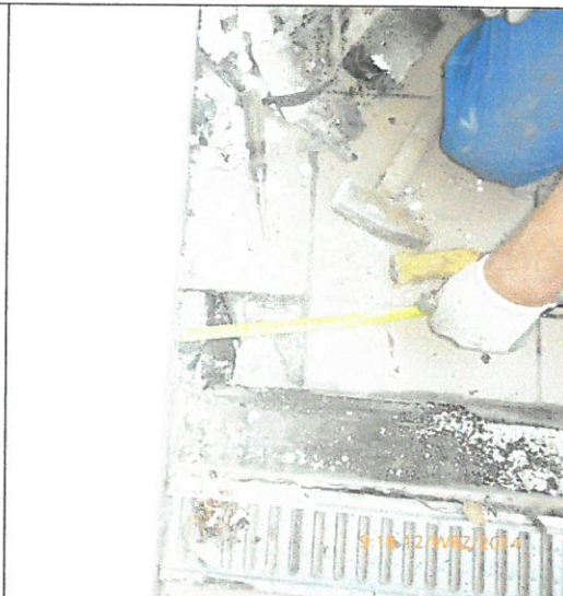
Fot. 24 Odkrywka nr 1 – okładzina i korytko odwadniające uszczelniane wtórnie, na ścianie 5 cm poniżej cokolika ceramicznego papa termozgrzewalna pas 14 cm, poniżej ułożono pas membrany przeciwwilgociowej (17 cm + 5 cm w poziomie), którą zabezpieczono w pionie styropianem o gr. 4 cm – mokro pod styropianem – brak membrany odsączającej
