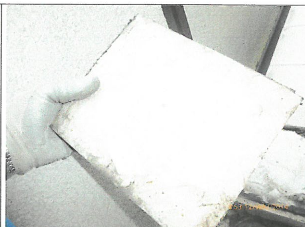
Fot. 30 Odkrywka nr 2 – spód płytki potwierdza brak prawidłowego przyklejenia do podłoża (narożniki i boki wolne od kleju)
