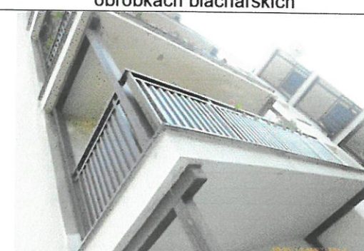
Fot. 40 Balkon – widoczne przecieki przez płytę balkonu
