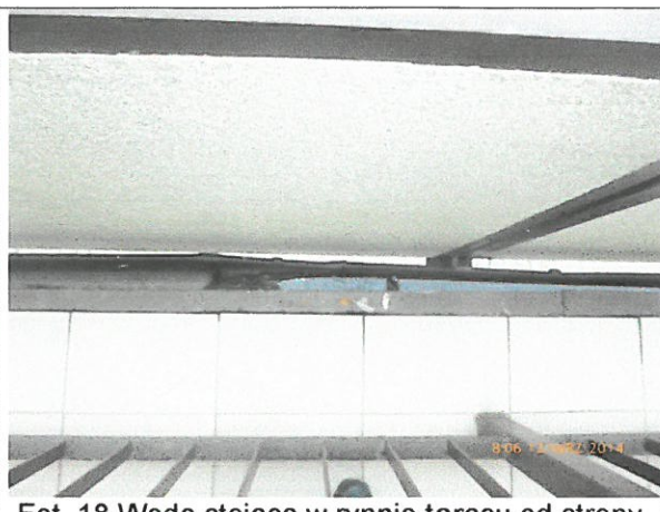
Fot. 18 Woda stojąca w rynnie tarasu od strony zachodniej
