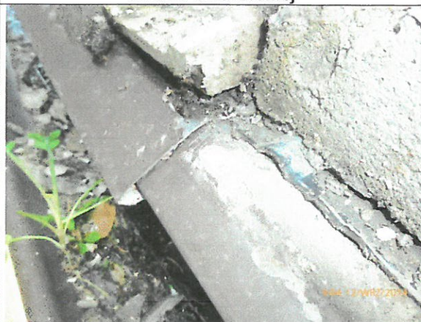
Fot. 34 Odkrywka nr 3 – płyta dociskowa na folii wyłożonej na obróbkę blacharską. Obróbka blacharska pod korytkiem odwadniającym wykonana, jako nakładka bez połączeń dekarских
