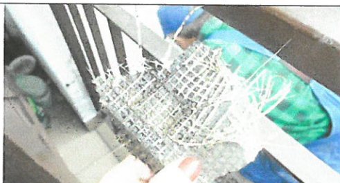
Fot. 25 Odkrywka nr 1 – w poziomie za membraną ok. 10 cm od ściany pobrano próbkę izolacji. Stwierdzono od góry: 2 cm płytki ceramiczne klejone, 7 cm płyta mineralna, izolacja CP 43 z siatką – masa uszczelniająca z zatopioną siatką z włókna szklanego nie jest równomiernie pokryta na powierzchni płyty, 7 cm płyta mineralna, 10 cm styropian - brak maty odsączającej
