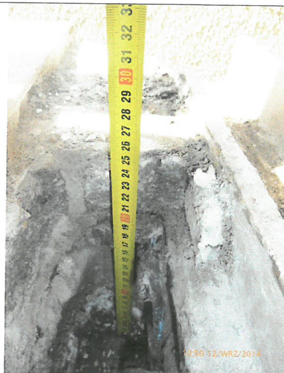
Fot. 36 Odkrywka nr 3 - Stwierdzono od góry: 2 cm płytki ceramiczne klejone, 7 cm płyta mineralna, 1 x izolacja z folii, 7,5 cm płyta mineralna, 10 cm styropian – mokro pod styropianem – brak maty odsączającej, CR 166 z siatką pokryta szczelnie w miejscu odkrywki
