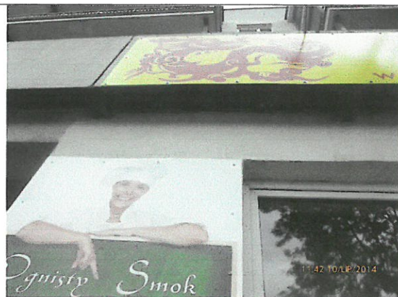
Fot. 12 Elewacja zachodnia lokalu „Ognisty smok” sąsiadująca z prześwitem – na rynajzach podłożono klocki drewniane w celu uzyskania odpływu wody z rynny
