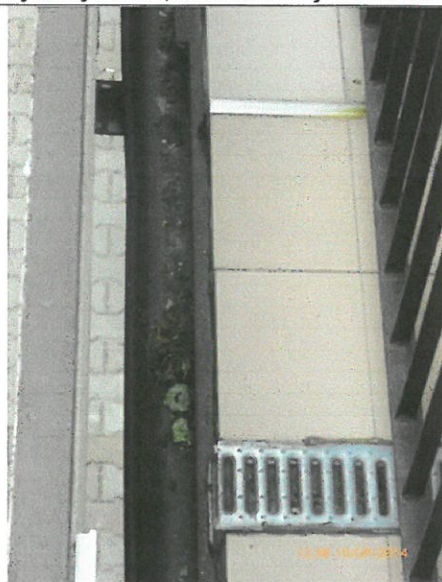
Fot. 13 Taras zachodni nad lokalem „Ognisty smok” – obróbki o różnej szerokości, kratka odwodnienia liniowego jest wyżej niż okładzina ceramiczna tarasu, a wylew z korytka jest wolny
